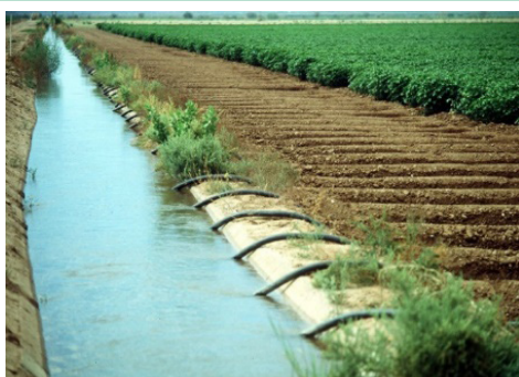
A. Canal irrigation
